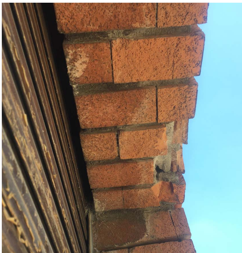
Pezzi speciali "ad angolo" del laterizio utilizzati a copertura degli architravi
