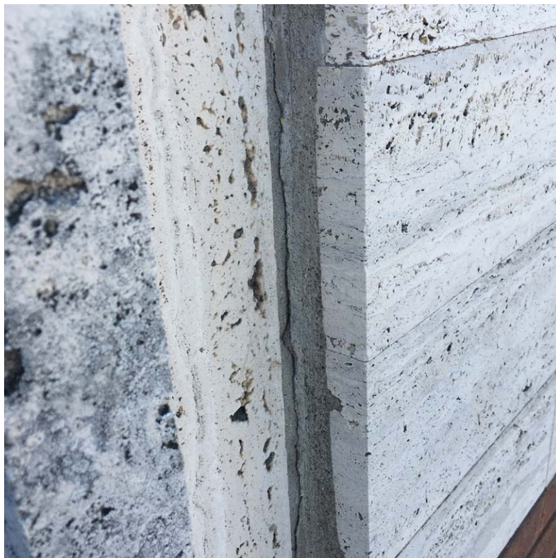
Particolare della fessura tra paramento di rivestimento in travertino e intonaco
