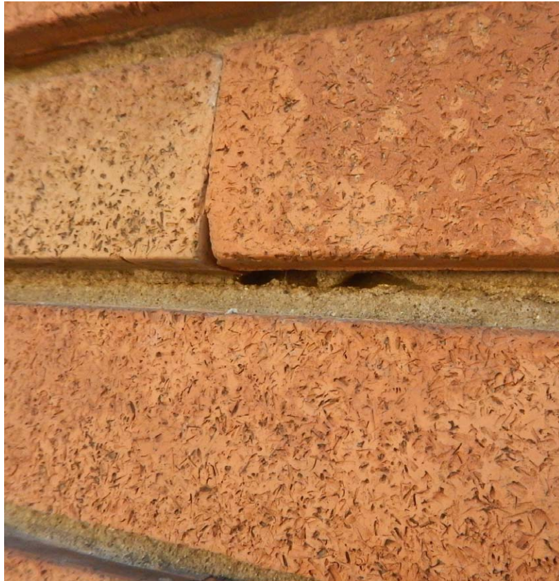
Particolare del giunto di malta ove necessario intervenire con risarcitura
