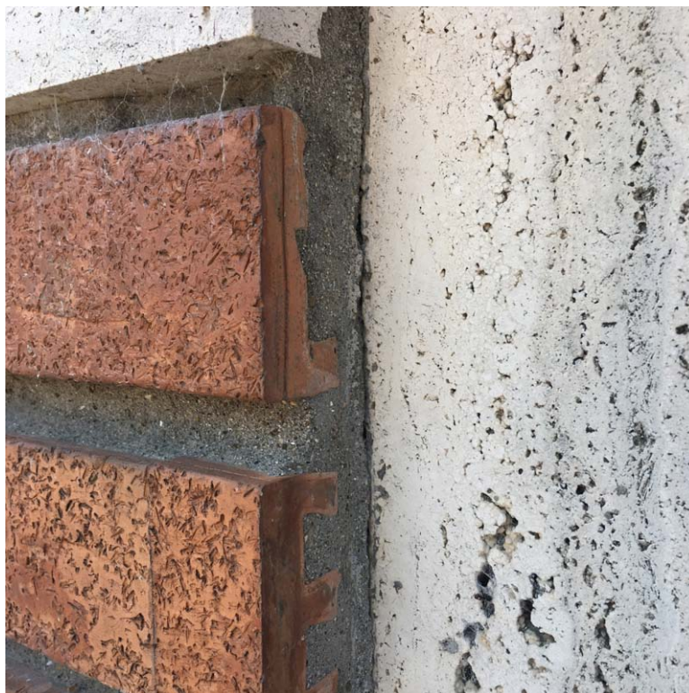
Particolare della fessura tra paramento di rivestimento in laterizio e intonaco
