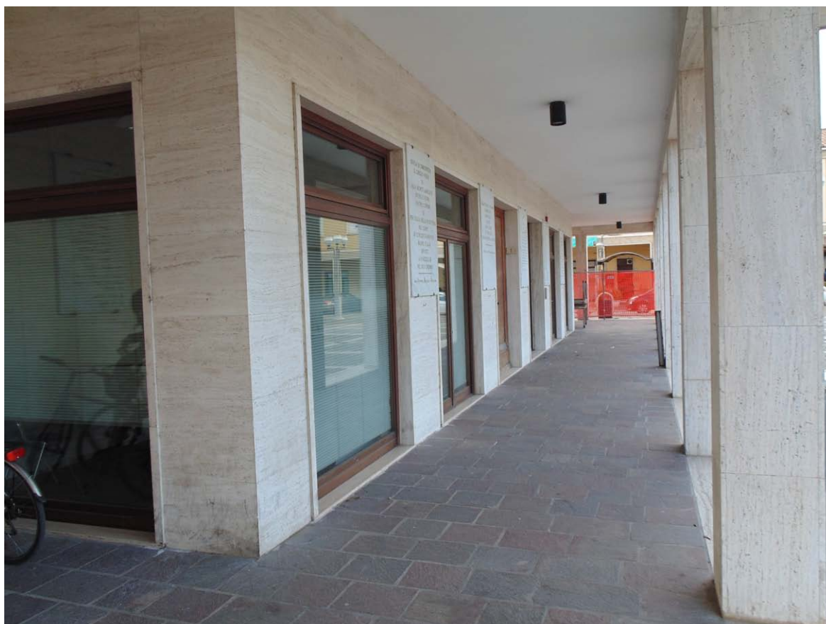
Lastre di travertino a rivestimento del portico
